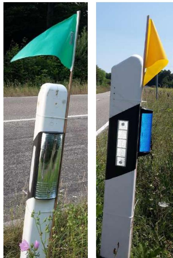
**Abb. 23:** Straßenleitpfosten mit montierten Fähnchen (li.: Abschnitt 18\_Ichenheim, re.: Abschnitt 5a\_Dimbach).
